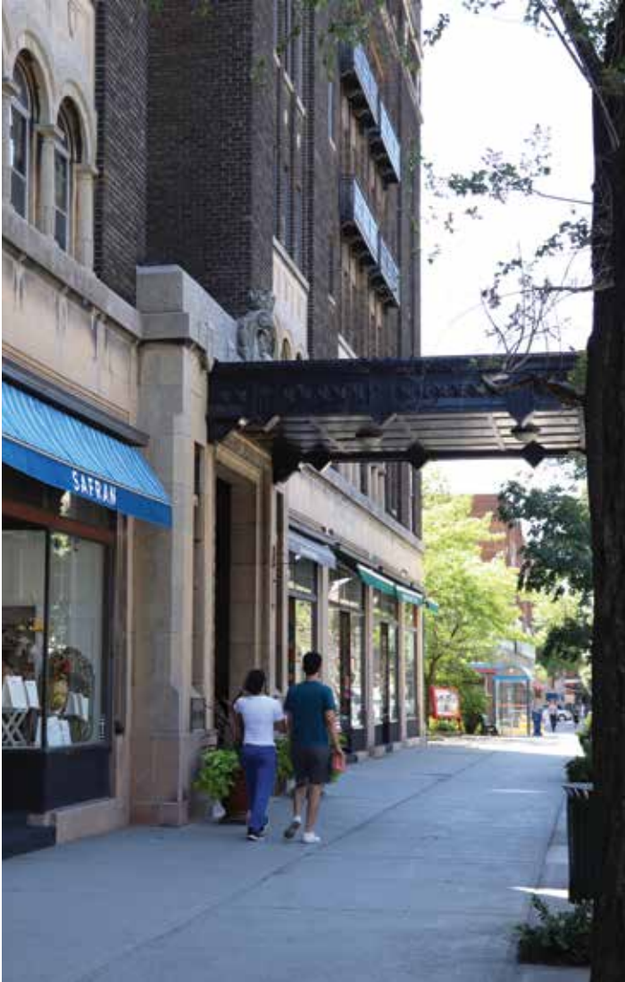
Passage sous la marquise de l'édifice résidentiel Royal York sur l'avenue Bernard, construit en 1928.
