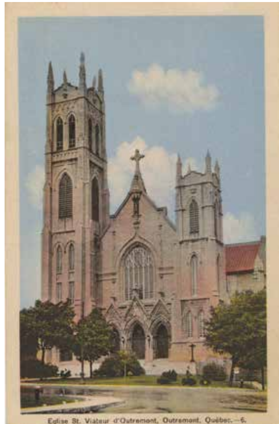
Église Saint-Viateur d'Outremont.
